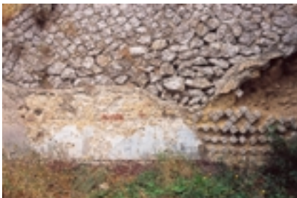
Salle de séjour (C) portant des traces d'enduit.
