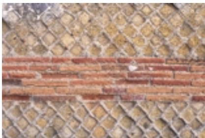
Opus reticulatum à rangées de briques.
